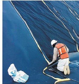
Fugas en Geomembranas - Seguimiento de Infiltrados.
